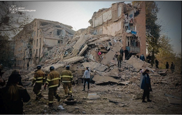
Des secouristes devant la partie effondrée
