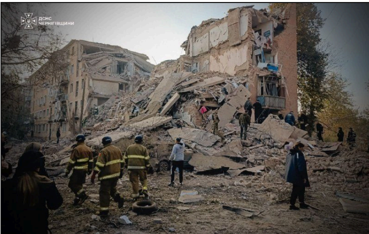
La cage d'escalier effondrée
