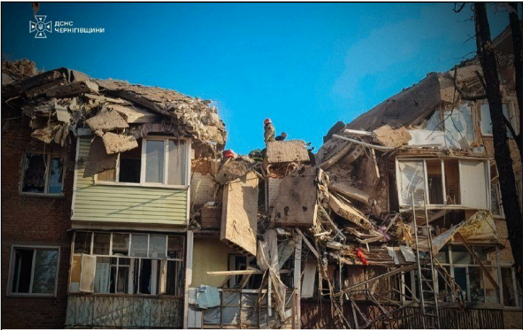
L'immeuble d'habitation de cinq étages à Pryluky après la frappe de missile Kh-101, 7 oct.
