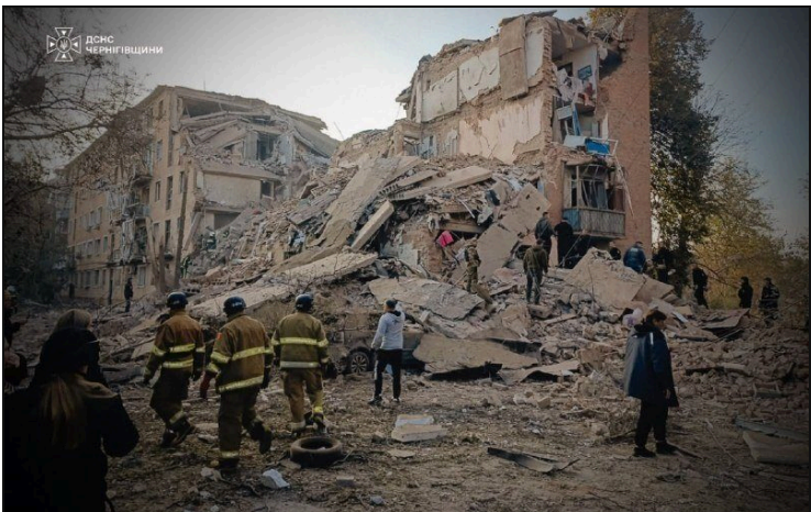
Обрушившийся подъезд ГСЧС Украины · 2026-10-07 · CC BY 4.0 https://t.me/dsns_telegram/76776
