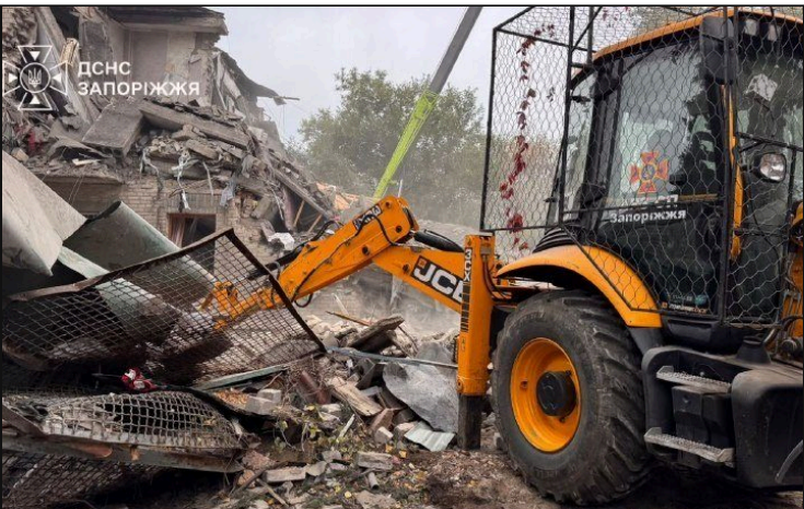
Una excavadora despeja la sección derrumbada
