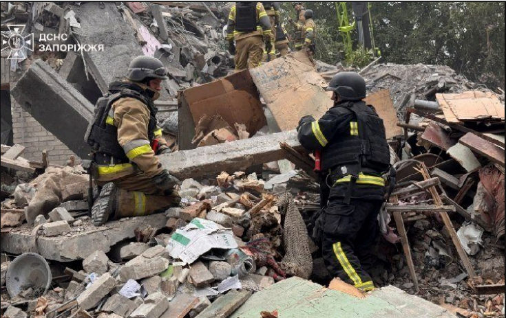
Des secouristes déblaient les décombres
