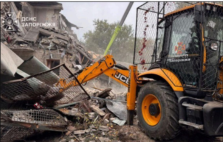
Экскаватор расчищает обрушившуюся секцию
