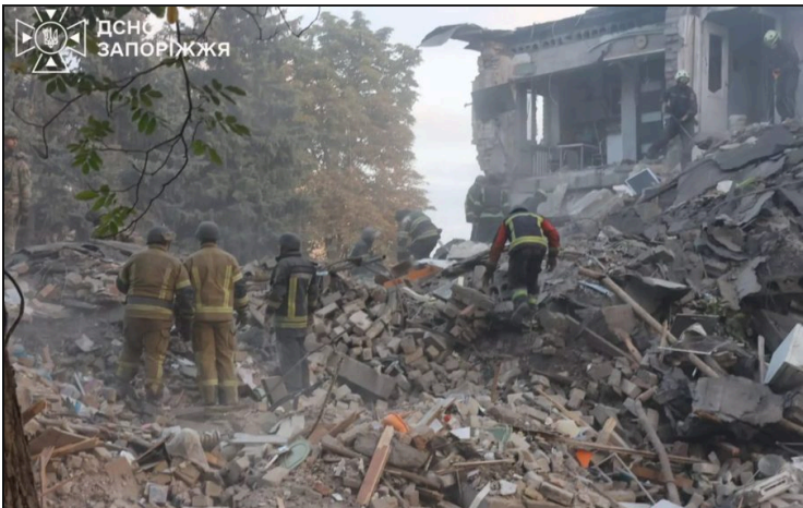
Запорожье: спасатели на обрушившемся подъезде, 11 октября
