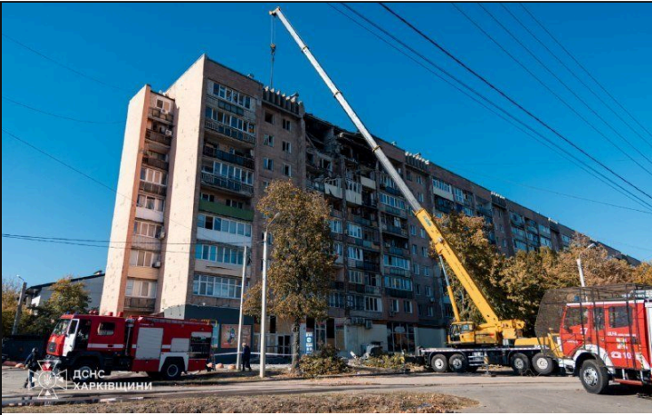
Kharkiv, 12 oct.: una grúa y camiones de bomberos junto al edificio de gran altura dañado
