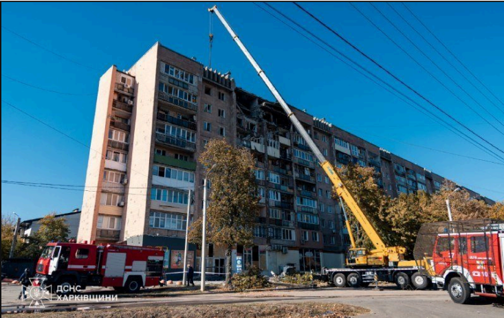
Kharkiv, 12 oct. : une grue et des camions de pompiers devant la tour endommagée
