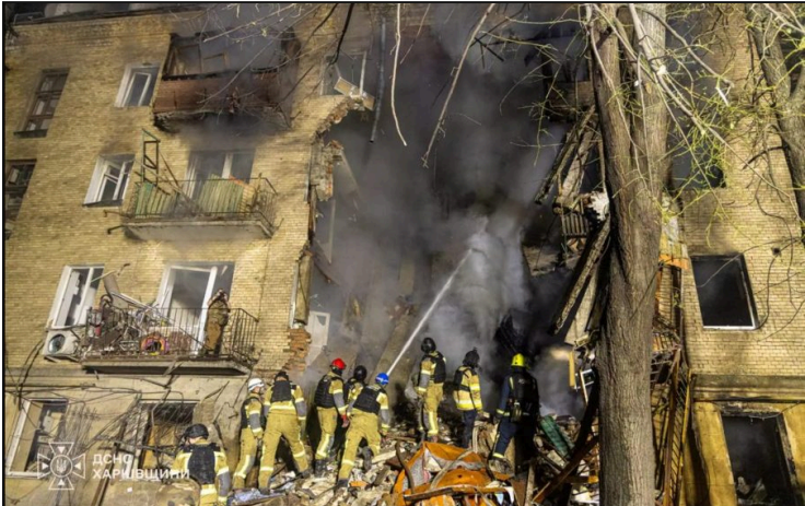
Kharkiv : des pompiers devant l'immeuble d'habitation dont la cage d'escalier s'est effondrée, 12 octobre
