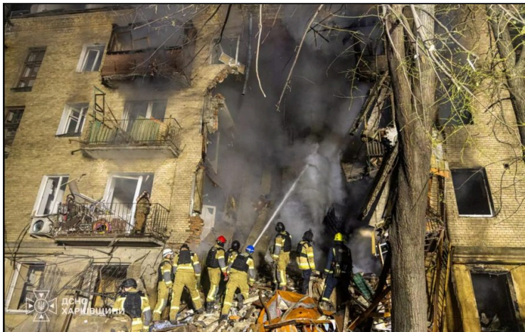
Харьков: пожарные у жилого дома с обрушившимся подъездом, 12 октября
