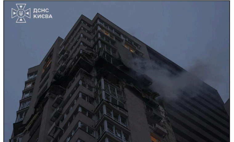
المبنى السكني المكوّن من 24 طابقاً في حي سفياتوشينسكي، كييف، بعد الضربة بطائرة مسيرة، فجر 21 أكتوبر
