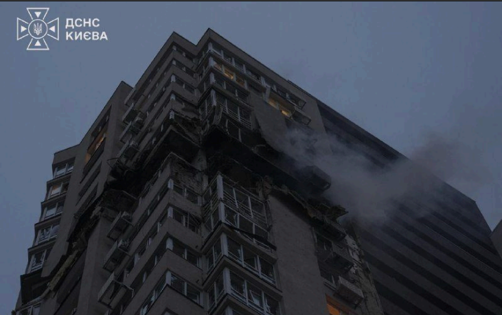
El edificio de viviendas de 24 plantas del distrito de Sviatoshynskiy, en Kyiv, tras el ataque con drones, en la madrugada del 21 oct.
