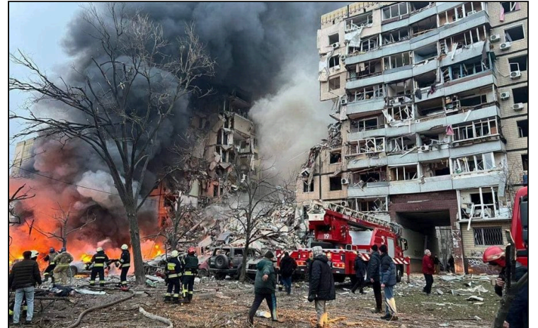
المبنى المؤلف من تسعة طوابق في شارع نابريجنا بيريموحي يحترق بعد الضربة، 14 يناير 2023
