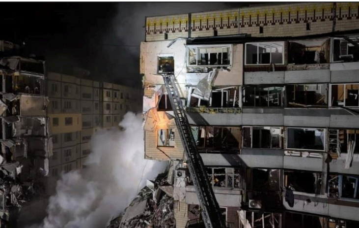
Socorristas en el portal derrumbado de noche
