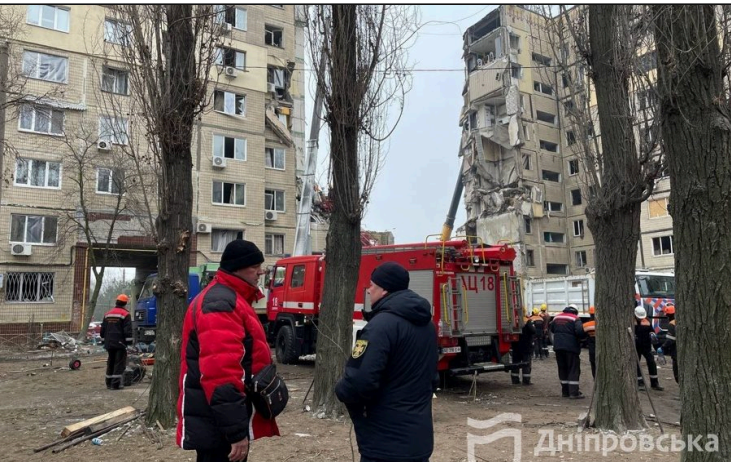
Residentes y socorristas frente al edificio
