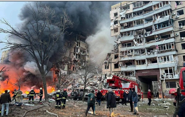
El edificio de nueve plantas de la calle Naberezhna Peremohy en llamas tras el ataque, 14 de enero de 2023
