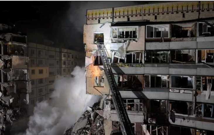
Des secouristes de nuit devant la cage d'escalier effondrée
