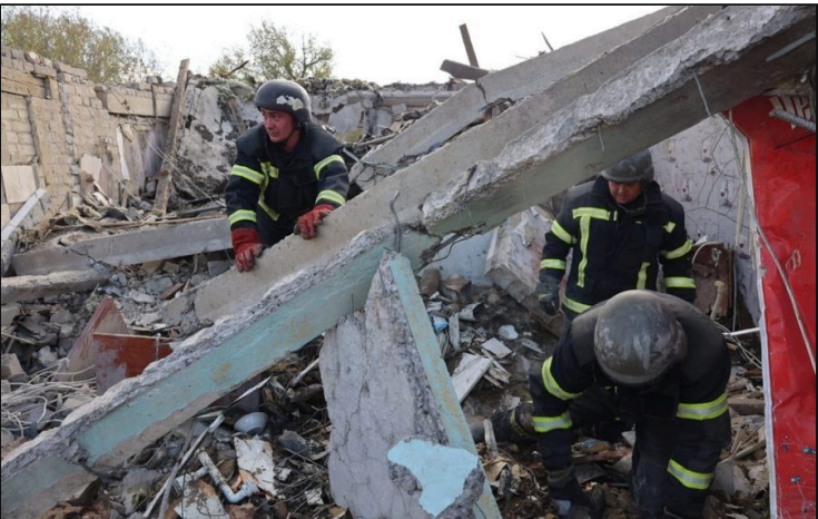
Des secouristes travaillent parmi les dalles effondrées du bâtiment
