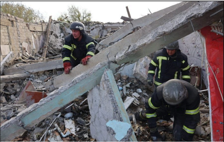
救援人员在建筑坍塌的楼板间作业
