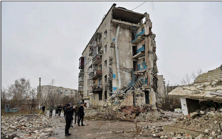
Ул. Первомайская, 2: обрушившаяся часть здания
