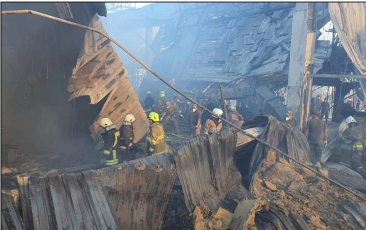
Des secouristes dans la structure effondrée
