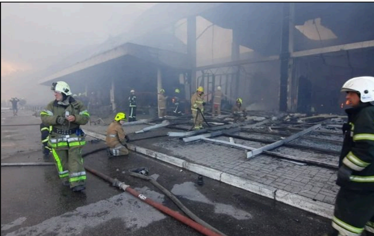
Des pompiers à l'intérieur du centre commercial en feu
