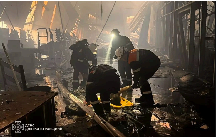
Rescatistas buscan dentro del edificio Servicio Estatal de Emergencias de Ucrania · 2026-08-25 · CC BY 4.0 https://commons.wikimedia.org/wiki/File:Shopping_center_in_Kryvyi_Rih_after_Russian_attack,_2026-08-21_(11).webp
