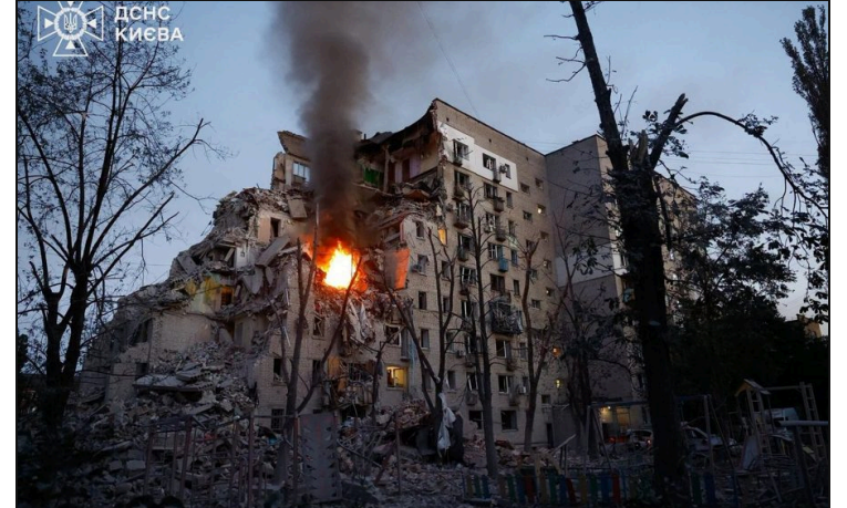
مبنى سكني يحترق في كيف ليلة 2 يوليو 2026
