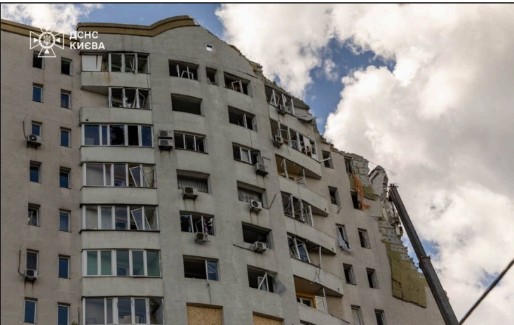
L'immeuble de 16 étages à la fin des opérations de secours
