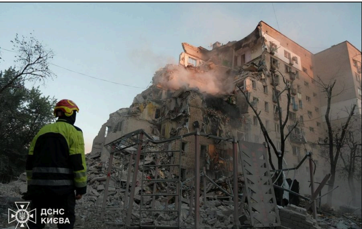
La section effondrée de l'immeuble d'habitation dans le district de Darnytskyï
