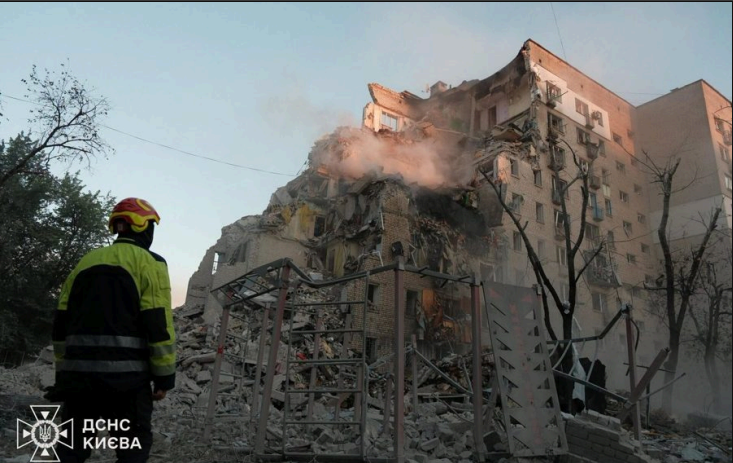
Обрушившаяся секция многоквартирного дома в Дарницком районе ГСЧС Украины · 2026-07-02 · CC BY 4.0 https://commons.wikimedia.org/wiki/File:Destructions_in_Kyiv_after_Russian_attack,_2026-07-02_(03).jpg
