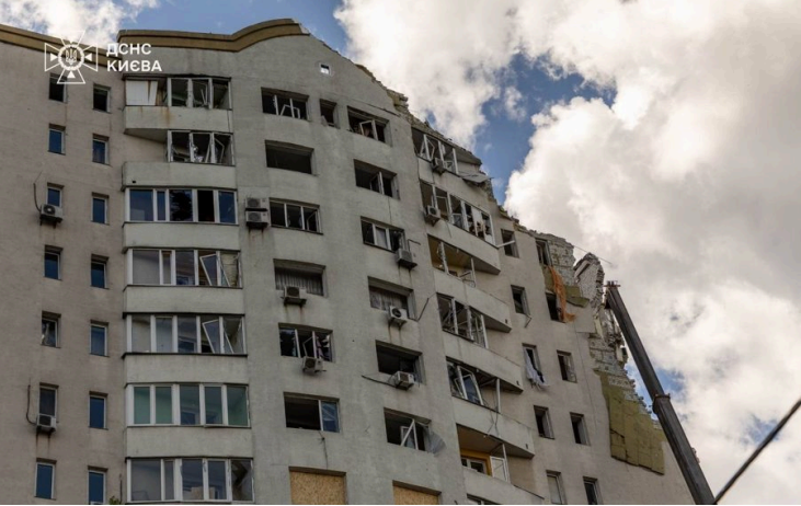
救援工作结束后的16层住宅楼 乌克兰国家紧急服务局 · 2026-07-02 · CC BY 4.0 https://commons.wikimedia.org/wiki/File:Destructions_in_Kyiv_after_Russian_attack_2026-07-02_(40).jpg
