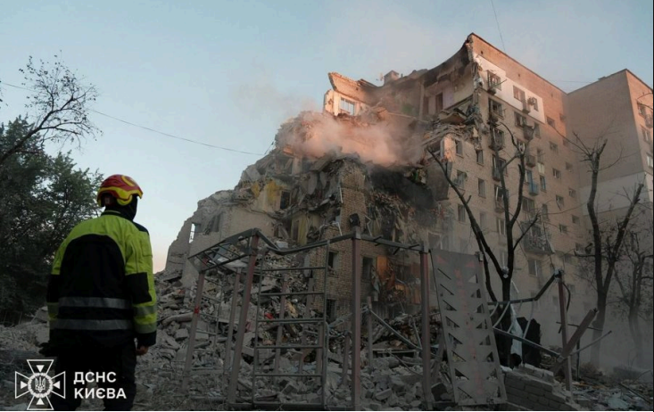
达尼茨基区公寓楼坍塌的单元楼段 乌克兰国家紧急服务局 · 2026-07-02 · CC BY 4.0 https://commons.wikimedia.org/wiki/File:Destructions_in_Kyiv_after_Russian_attack_2026-07-02_(03).jpg
