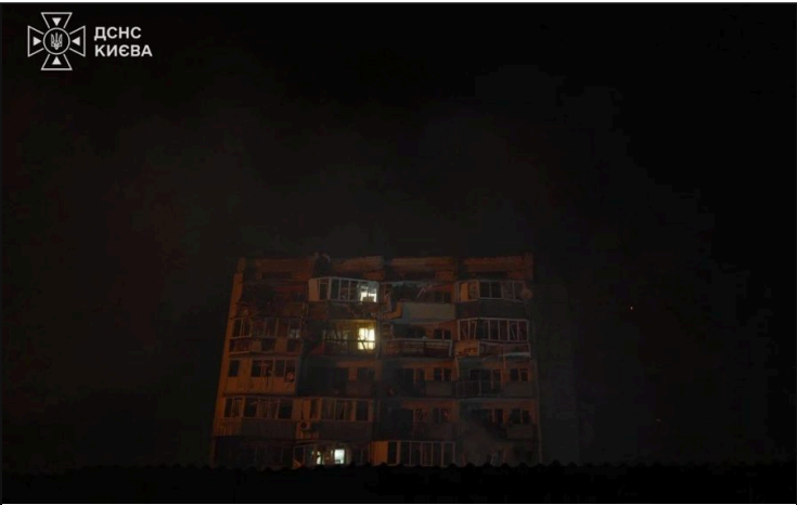
Святошинский район после ночной атаки 20 августа 2026 года — материал АрмияInform, кадр 1 из 3 ArmyInform · 2026-08-20 · CC BY 4.0 https://armyinform.com.ua/2026/08/20/ataka-na-kyiv-4-zagyblyh-i-23-poranen-yh-rujnuvannya-v-troh-rajonah-stolyczi/
