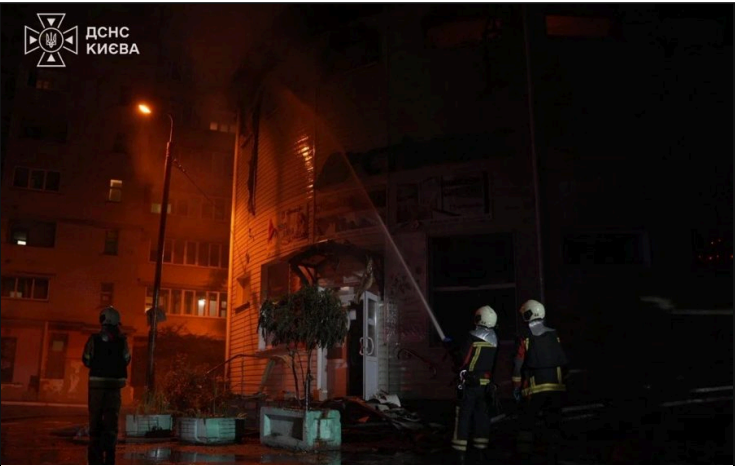
2026年8月20日夜间袭击后的斯维亚托申斯基区——ArmyInform 发布，第2/3张 ArmyInform · 2026-08-20 · CC BY 4.0 https://armyinform.com.ua/2026/08/20/ataka-na-kyiv-4-zagyblyh-i-23-poranen-yh-rujnuvannya-v-troh-rajonah-stolyczi/
