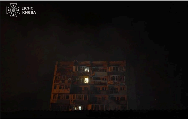
2026年8月20日夜间袭击后的斯维亚托申斯基区——ArmyInform 发布，第1/3张 ArmyInform · 2026-08-20 · CC BY 4.0 https://armyinform.com.ua/2026/08/20/ataka-na-kyiv-4-zagyblyh-i-23-poranen-yh-rujnuvannya-v-troh-rajonah-stolyczi/
