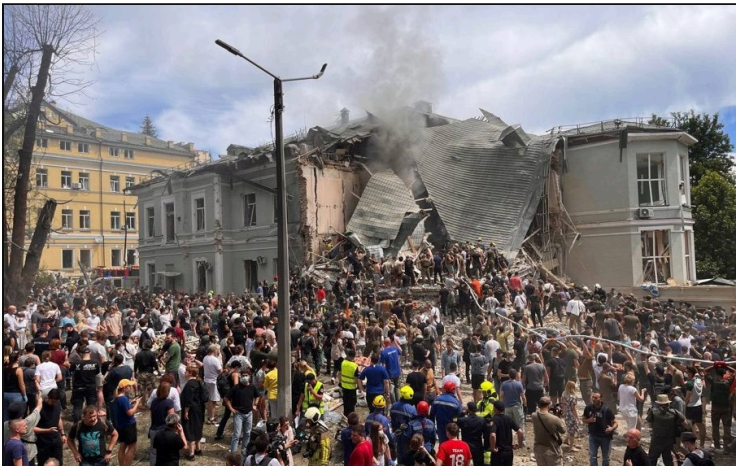
El hospital infantil Okhmatdyt minutos después del ataque, 8 jul. 2024: humo sobre el edificio de toxicología y multitud de rescatistas y voluntarios
