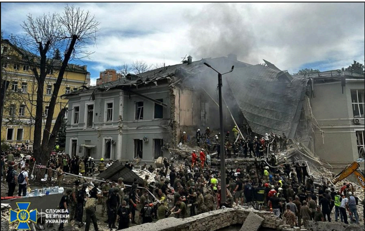
Разрушенный токсикологический корпус «Охматдета»
