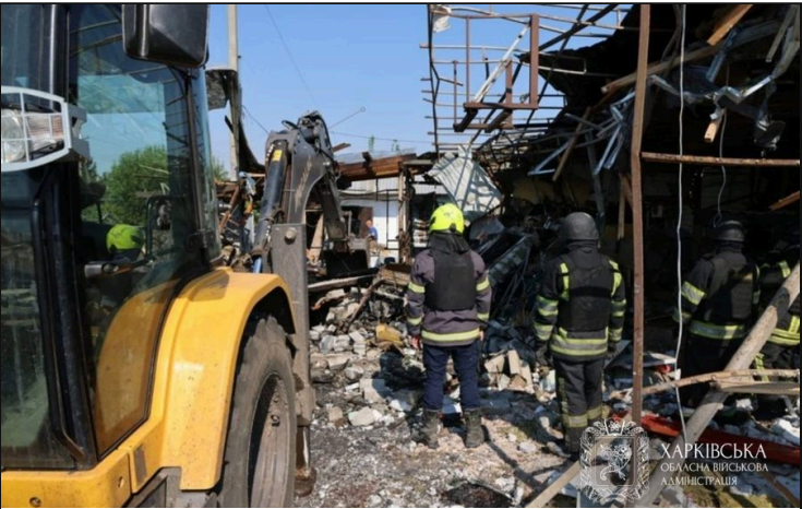
Le centre de Petchenihy après la frappe de missiles du 18 août 2026 — publication de l'administration régionale, image 3 sur 6
