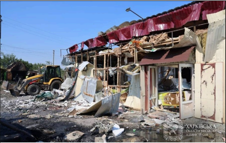
Le centre de Petchenihy après la frappe de missiles du 18 août 2026 — publication de l'administration régionale, image 6 sur 6
