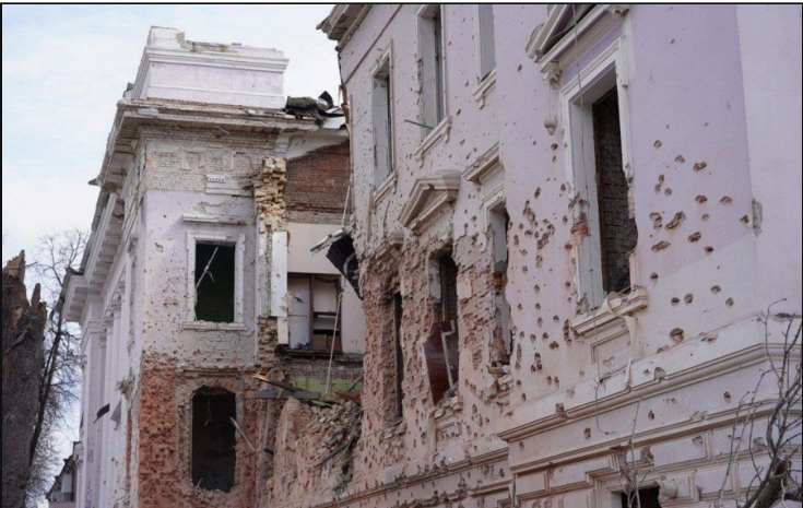
袭击后位于彼得罗巴甫洛夫斯卡街57号的苏梅国立大学一栋建筑 乌克兰国家警察 · 2025-04-13 · CC BY 4.0 https://commons.wikimedia.org/wiki/File:Destructions_in_Sumy_after_Russian_attack_2025-04-13_(04).jpg
