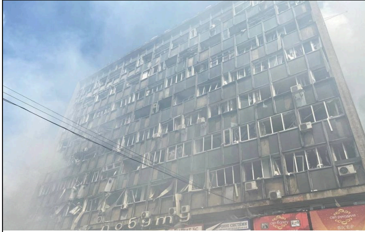
مبنى المكاتب المقابل وقد تحطمت نوافذه
