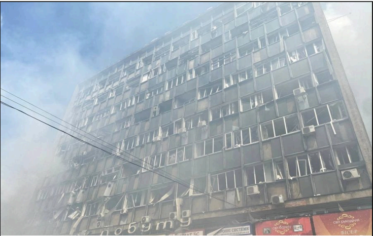
El edificio de oficinas de enfrente, con las ventanas reventadas
