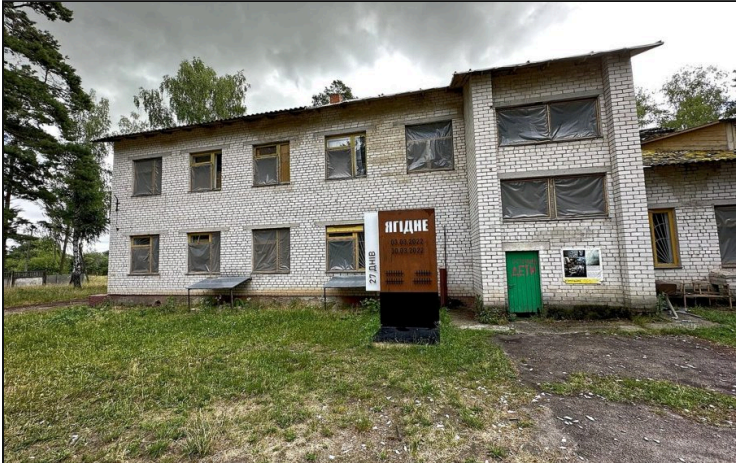
Школа в Ягодном, в подвале которой 28 дней удерживали всё село
