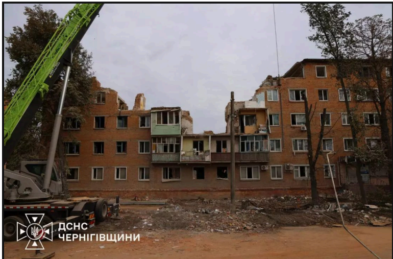
بريلوكي، 8 أكتوبر: المبنى بعد الضربة. الصورة: خدمة الطوارئ الحكومية، منطقة تشرنيهيف · CC BY 4.0 · cn.dsns.gov.ua
