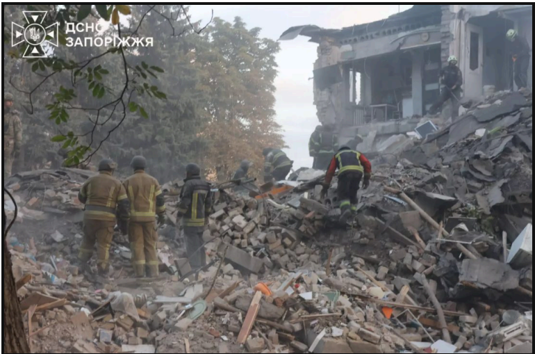
扎波罗热，10月11日：救援人员在倒塌的单元上作业。照片：国家紧急服务局扎波罗热州分局 · CC BY 4.0 · zp.dsns.gov.ua
