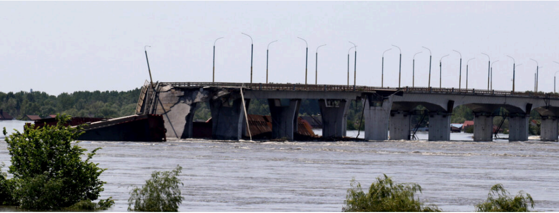
7 juin 2023 : le pont Antonivskyi détruit — la route de Kherson à Olechky — au-dessus de l'inondation après la destruction du barrage de Kakhovka. Photo : Dmytro Zavtonov / ArmiyaInform, Wikimedia Commons, CC BY 4.0.
