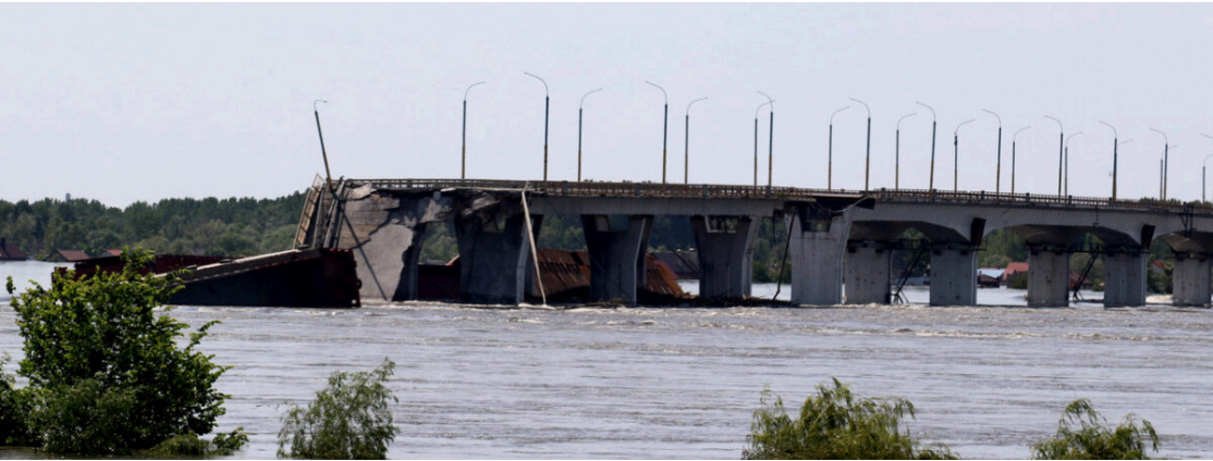
7 июня 2023 года: разрушенный Антоновский мост — дорога из Херсона в Олешки — над затопленной местностью после подрыва Каховской плотины. Фото: Дмитрий Завтонов / АрмияInform, Wikimedia Commons, CC BY 4.0.
