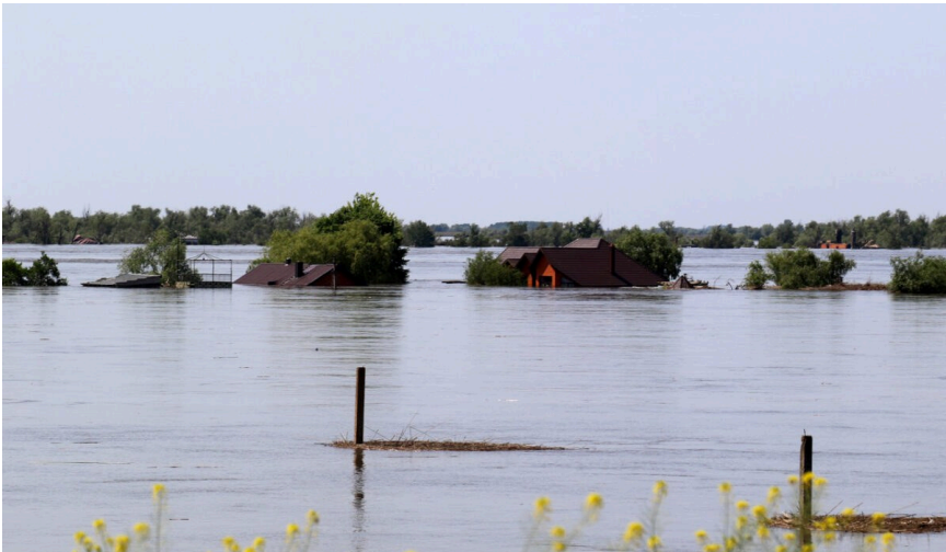
Kherson au lendemain de la destruction du barrage, 7 juin 2023. Photo : Дмитро Завтонов / АрміяInform · CC BY 4.0 · via Wikimedia Commons
