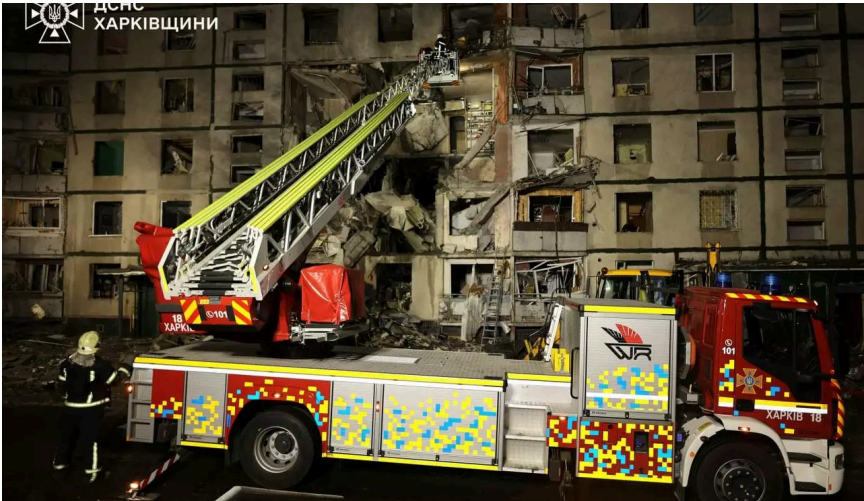
国家紧急服务局的云梯车停在受损居民楼旁，2024年10月30日至31日夜间。照片：乌克兰国家紧急服务局哈尔科夫州分局 · CC BY 4.0 · 来自官方网站
