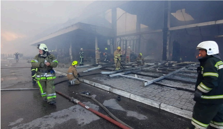
Pompiers à l'intérieur du centre commercial en feu. Photo : Service d'urgence de l'État d'Ukraine · CC BY 4.0 · via Wikimedia Commons
