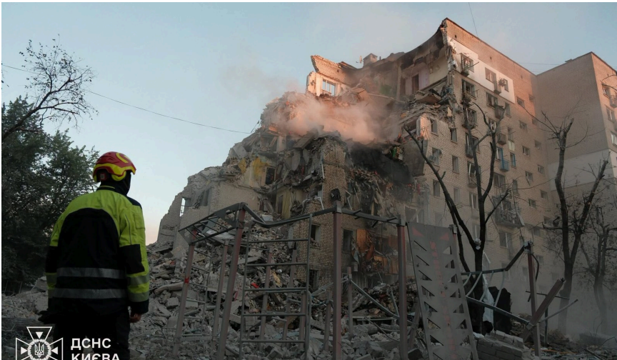
La sección derrumbada del edificio de viviendas en el distrito de Darnytskyi. Foto: Servicio Estatal de Emergencias de Ucrania · CC BY 4.0 · vía Wikimedia Commons
