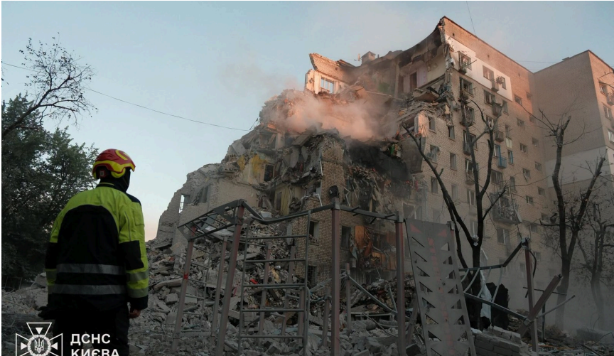
La partie effondrée de l'immeuble d'habitation dans le district de Darnytskyi. Photo : Service d'urgence de l'État d'Ukraine · CC BY 4.0 · via Wikimedia Commons
