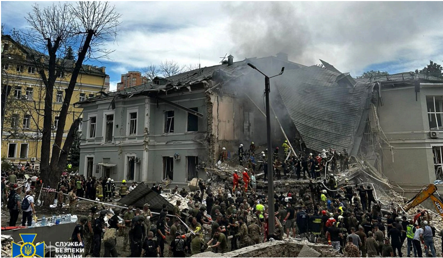
El edificio de toxicología de Okhmatdyt, destruido. Foto: Servicio de Seguridad de Ucrania · CC BY 4.0 · vía Wikimedia Commons
