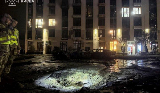
Kyiv : le site après la frappe · Service d'urgence de l'État d'Ukraine (DSNS) · 2026-10-12 · CC BY 4.0
